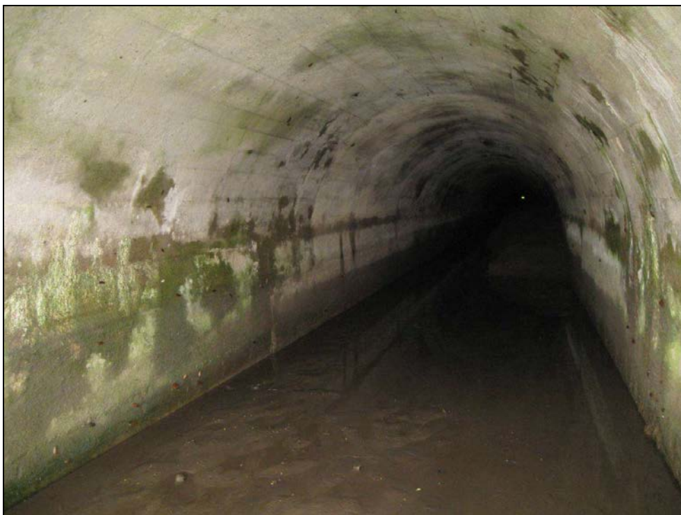
Obr. č. 2 - pohled do objektu těsně za pravým čelem. Spodní stavba a klenba je z monolitického betonu, povrch betonu je bez poruch. Hloubka usazenin zde je min. 0,6 m
