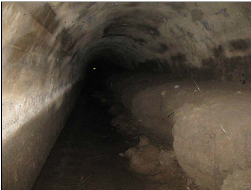
Obr. č. 3 - pohled do objektu cca 20 m od pravého čela. Spodní stavba a klenba je z monolitického betonu, povrch betonu je bez poruch. Hloubka usazenin zde je min. 0,3 m, navíc jsou zde do výše cca 1,0 m pod klenbou usazeniny u opěry Plzeň.
