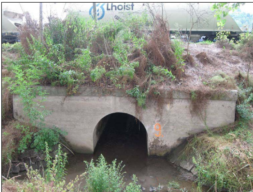
Obr. č. 1 - pohled na objekt zprava, na této straně je z propustku výtok. Dochází zde k sedimentaci usazenin a je zde trvale stojící voda.
