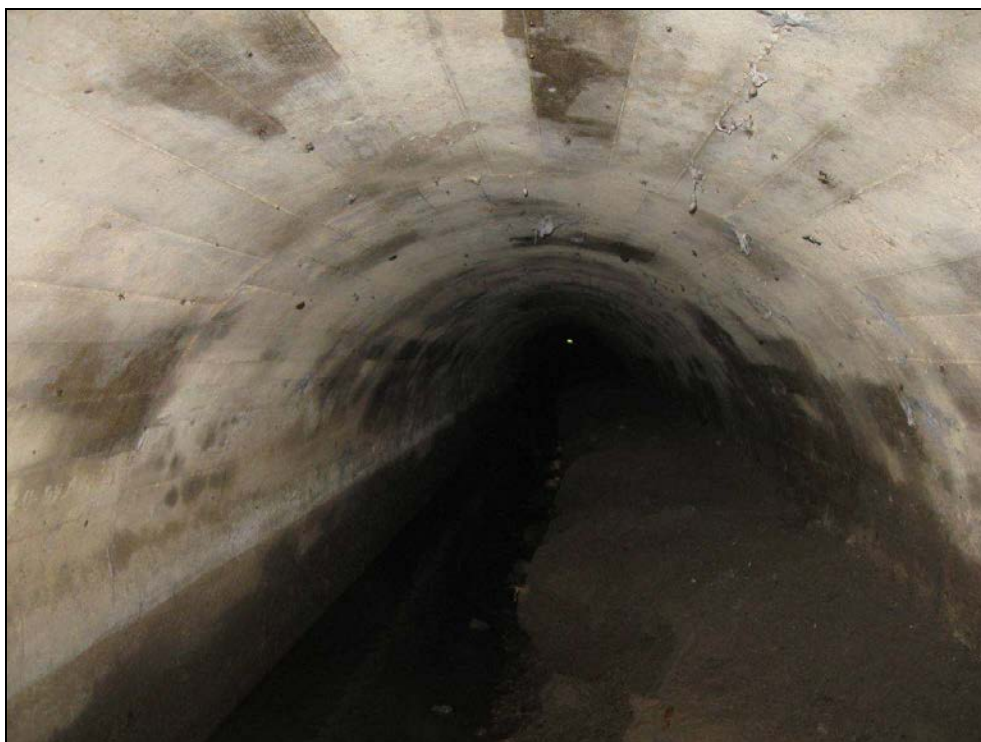
Obr. č. 4 - detailní pohled na klenbu z monolitického betonu v části pod hlavními kolejemi, tj. cca 30 m od pravého čela.
